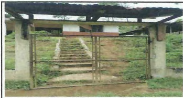
Foto 6: Sustitución de portón en mal estado que presenta oxidación y poca movilidad.
