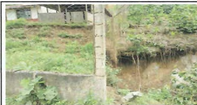
Foto 3: Rehabilitación de cerco de muro perimetral debido a que se presentó un derrumbe de tierra en el terreno vecino que afectó a la escuela.
